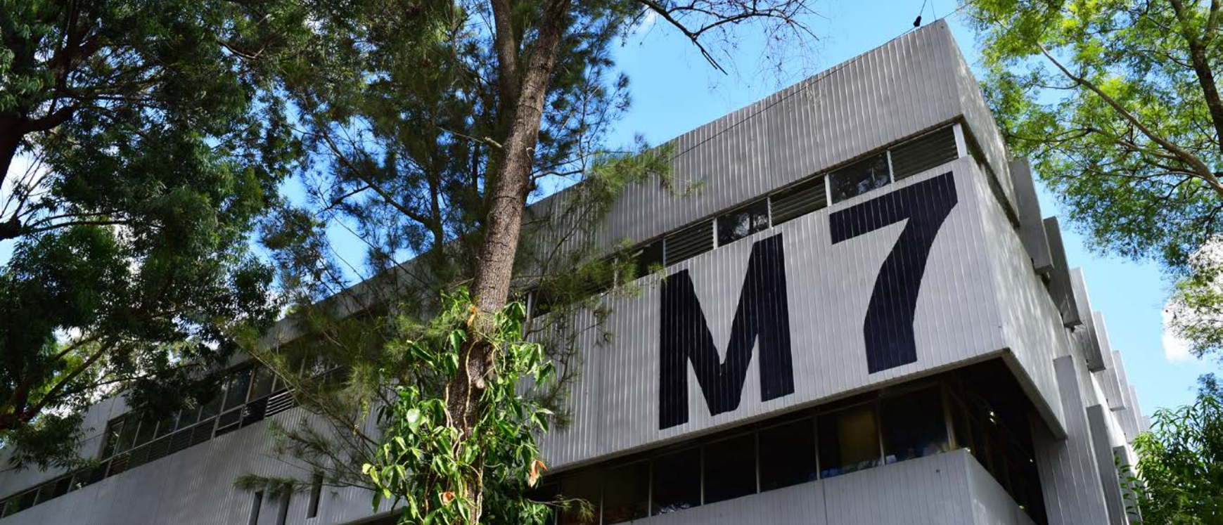
Imagen 33 – Edificio M7 de la Facultad de Medicina Veterinaria y Zootecnia de la USAC.
